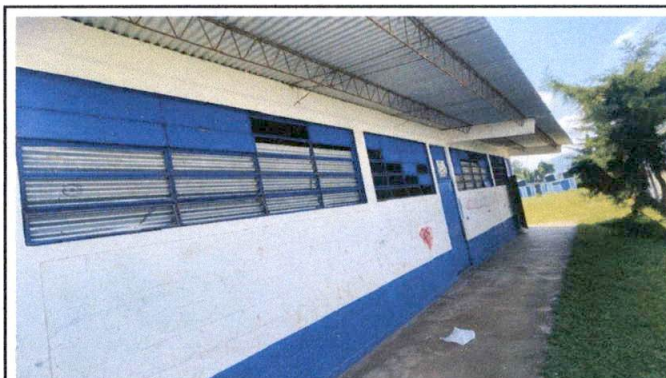
Foto 4: Fachada frontal modula de aulas
