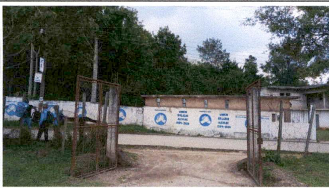
Foto 9: Ingreso a la escuela
