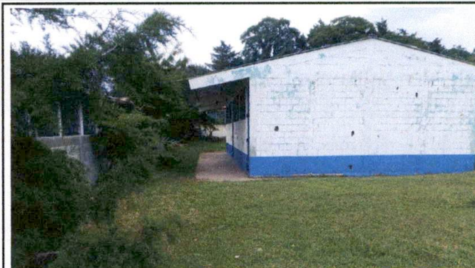
Foto 2: Fachada lateral modulo de aulas
