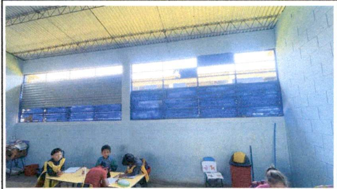
Foto 8: Ventanales en aulas
